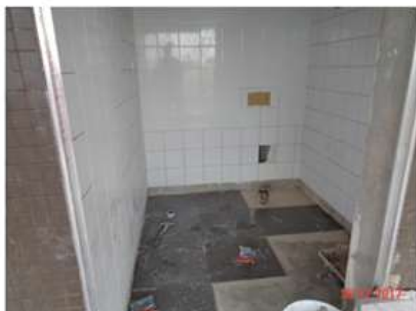
Execução do revestimento dos sanitários públicos do mezanino.
