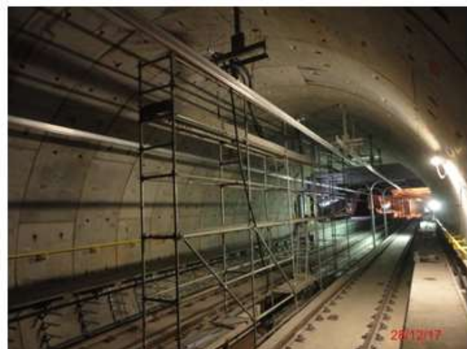
Trecho Eucaliptos - Moema: Instalação de rede aérea
