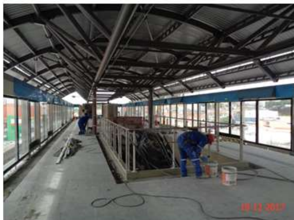
Tratamento do concreto na mureta do vão da escada.
