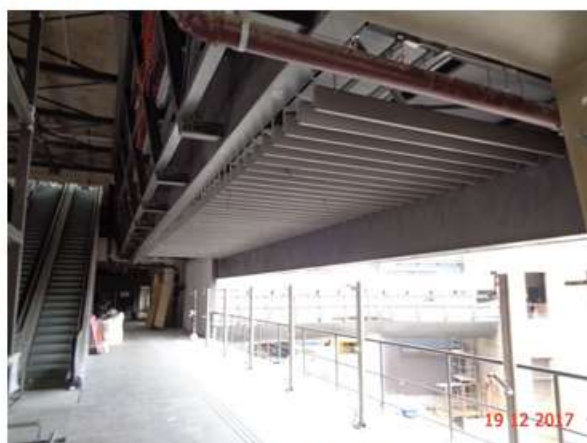
Iniciada a instalação do forro metálico do mezanino.
