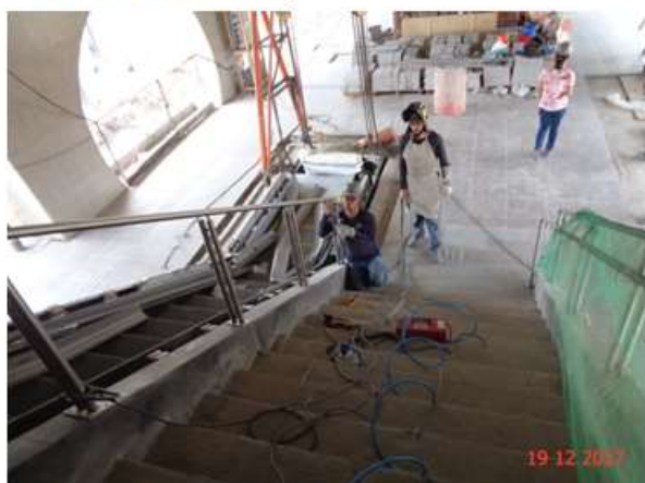
Instalação do corrimão na escada de acesso à plataforma.
