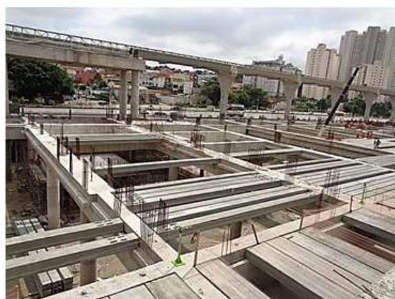
Execução de pilares, vigas e lajes.
