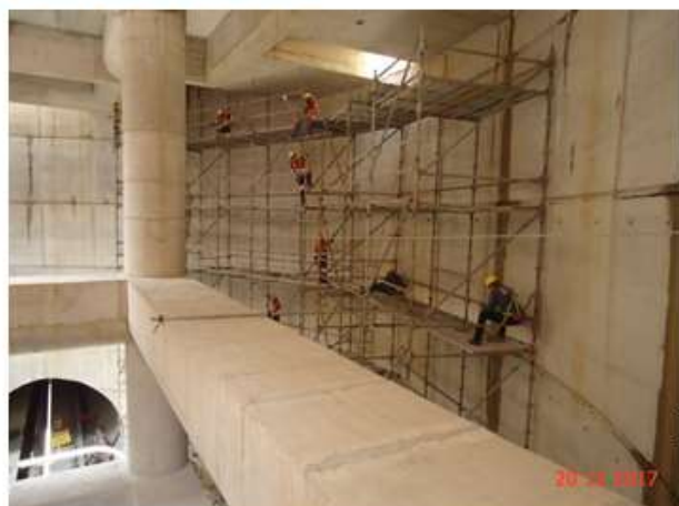
Corpo da estação – Poço 1: Tratamento de concreto
