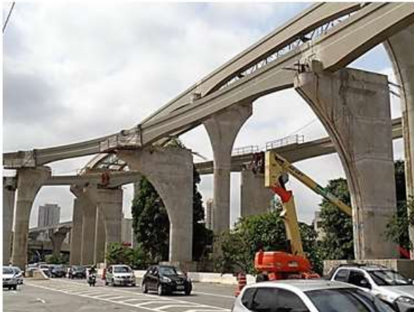
Lançamento de vigas guia curvas.
