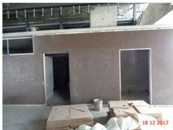
Execução do revestimento externo e instalação dos contramarcos dos sanitários públicos do mezanino.
