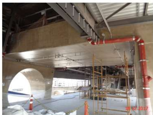
Execução do piso de granito, forro e instalação da rede de águas pluviais.
