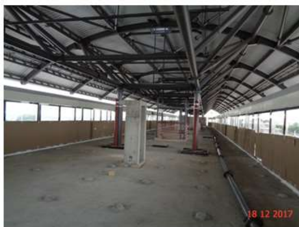
Preparação para concretagem do contrapiso de concreto da plataforma.
