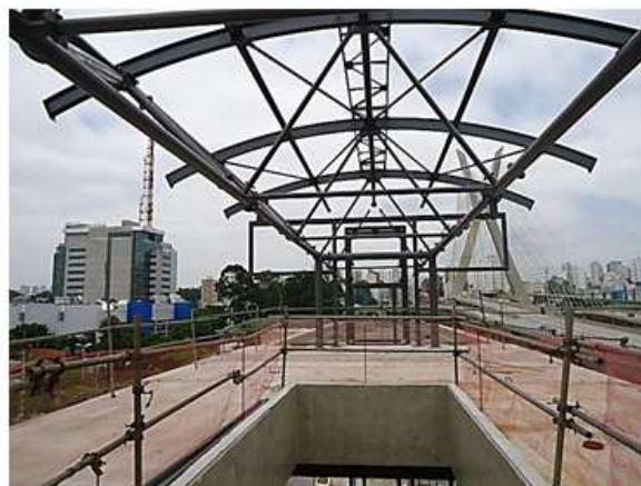
Instalação da cobertura metálica da Estação
